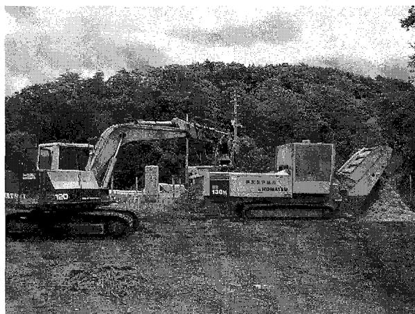
写真-3 専用土場Bの粉碎作業
