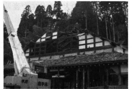
f 妻面解体
