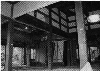
d 建具のみの内部
