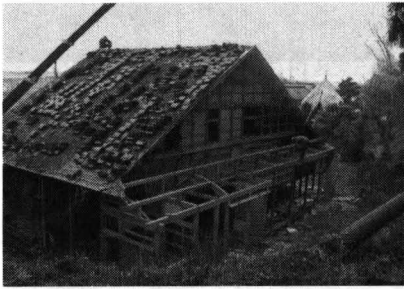
a 瓦の撤去
