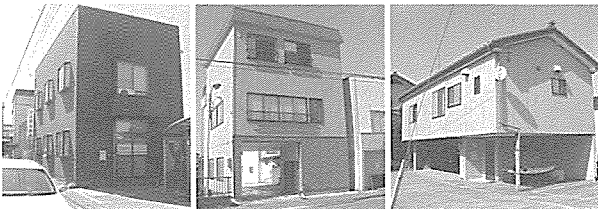
図20 無被害・被害軽微な鉄骨造（柏崎市）
