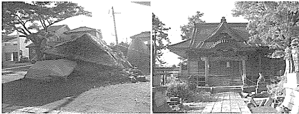
ア) 本殿の倒壊 イ) 拝殿は変形・脚部移動 図6 柏崎神社の被害(柏崎市西本町)
