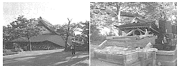
ア) 本堂の倒壊 イ) 鐘楼堂の倒壊
