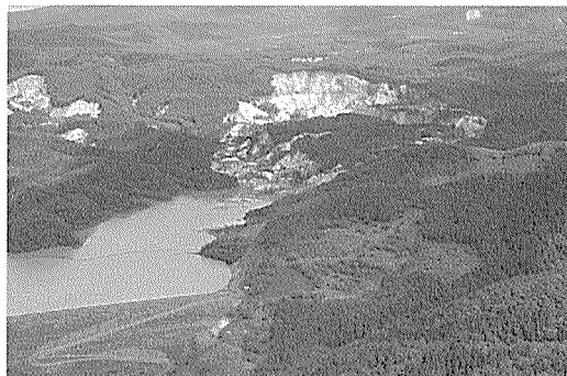
写真3 荒砥沢地すべりと荒砥沢ダム 崩土のすべり方向は対岸に向かっている。これにより、ダム湖への突入・越流という最悪の事態は避けられた。
