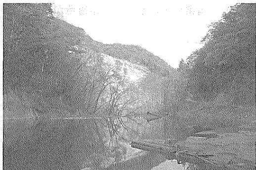
写真13 湯ノ倉温泉付近の湛水状況 奥に見える崩壊により湛水し、温泉の建物が流出している。
