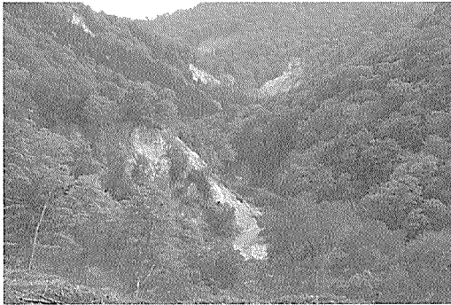
写真12 一迫川支流原小屋沢の様子 無数の小規模の崩壊が発生している。
