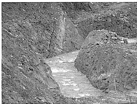
写真1 市野々原地区地すべりの捷水路の河道掘削面に現れた古い断層
