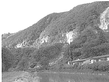
写真10 温湯付近に見られるトップリング （節理の崩落による落石）
