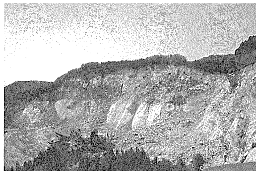
写真4 荒砥沢地すべりの滑落崖 上部の溶結凝灰岩と下部の湖成層との境界がはっきり見える。
