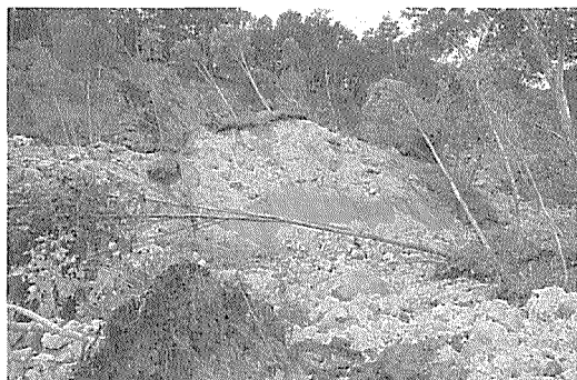
写真7 耕英地区冷沢の荒廃状況 樹木を乗せたまま小ブロックで移動している。樹木は後方に回転している。
