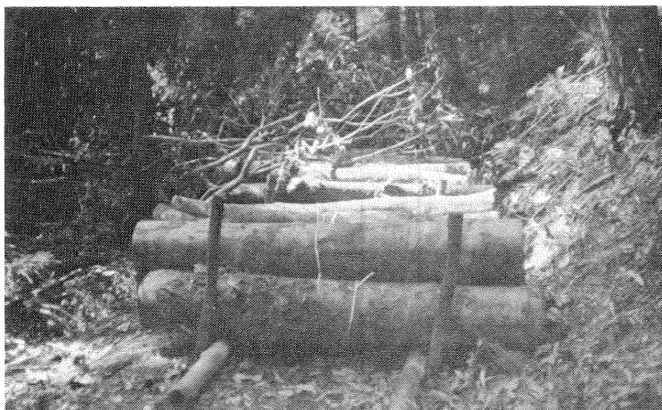
アラカシ，イタジイの伏せ込み 作業道の活用
