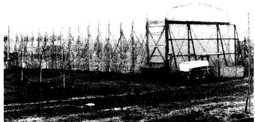
写真2 降雨遮断施設が閉じている状態
