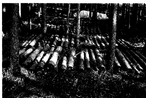
図－２ 地伏せによる伏込み（展開）状況
