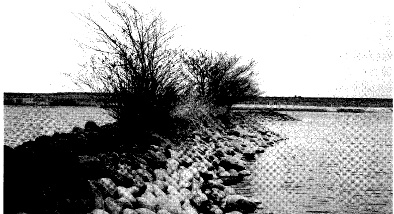
写真-2 水制工に植栽されたヤナギ
