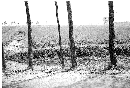
写真9 二次水路 (道路に平行) と三次水路 (二次水路に直角) (Bac Ninh 県). 低地で、表1の作付体系では2の稲-稲地帯.
