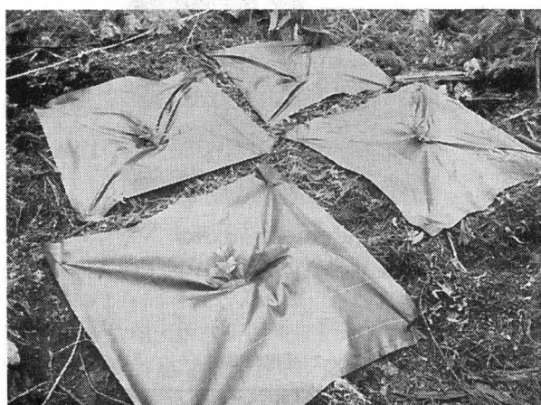
図-3 マルチシートの敷設状況
