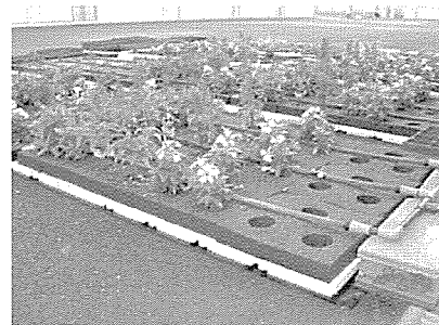
第3図 固化基盤の設置方法
