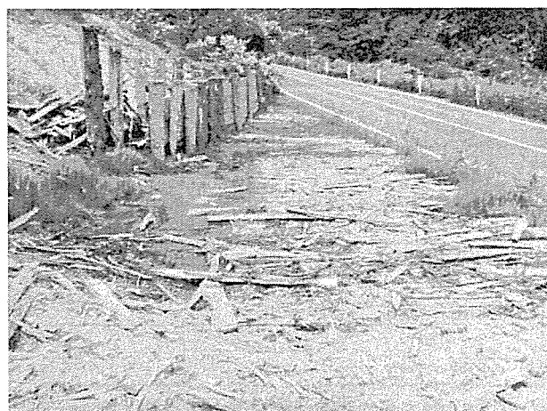
写真7 長岡市大積三島谷町 (H20.5) 背板敷設状況
