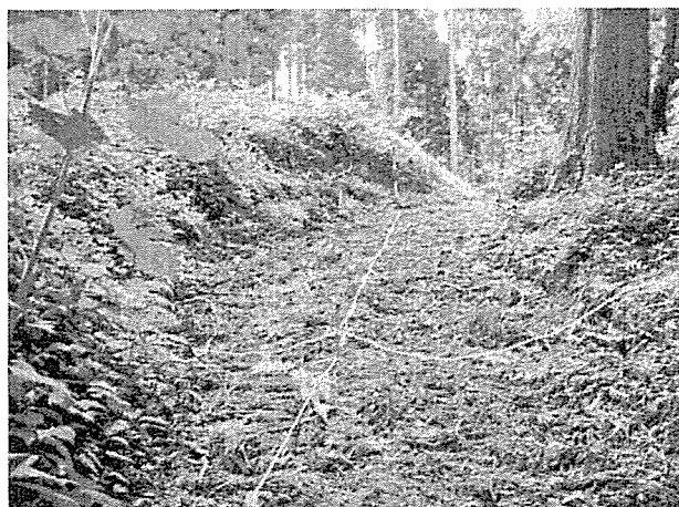
写真6 長岡市大積三島谷町 (H21.6) 路面状況
