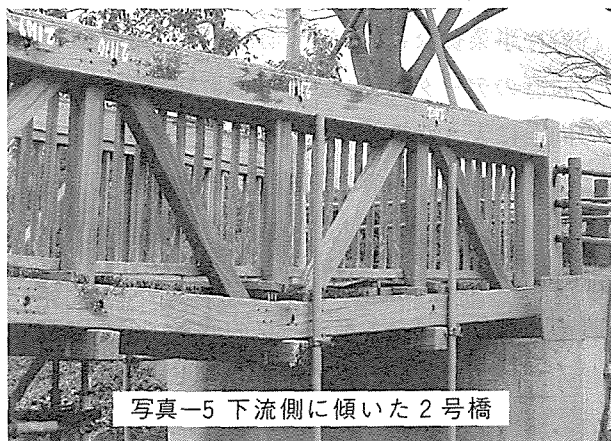
写真-3 下流側に傾いた2号橋
