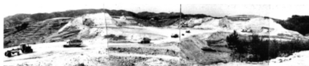
福山市東部日本鋼管住宅団地造成中の景観（水野組KK古村良雄氏の好意による）
