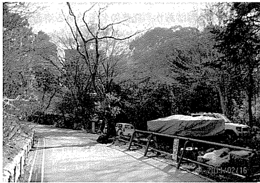
写真3 写真2と同一場所、現況
