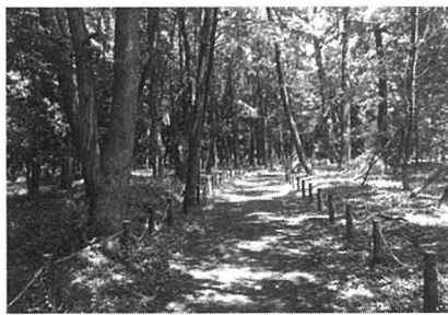
写真3 遊歩道の設置
