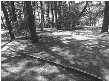
写真4 多目的広場の造成
