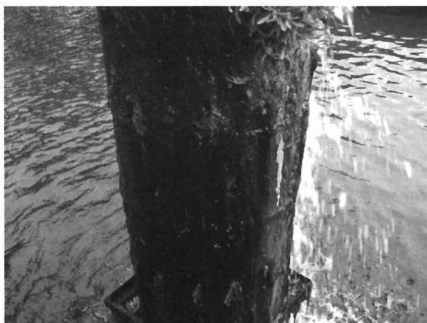
図7 曝気塔に繁殖した着臭原因藻類
