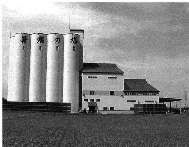
図8 米のカントリーエレベータのサイロ群 （北海道雨竜町ライスコンビナート） 粳貯蔵能力480 t × 12 基 = 5760 t
