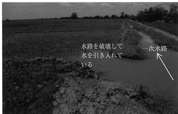
図6 アワチスキームにおいて農民が一次水路を壊して自分の水田に水を引いている様子
