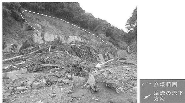
写真12 主溪流における崩壊地直下の倒木の堆積状況
