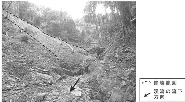
写真4 支溪流の溪流に面した斜面の状況
