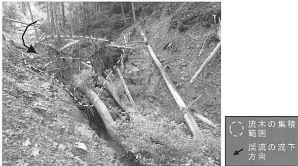
写真10 支溪流における流路狭窄部の流木の堆積状況
