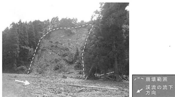
写真6 主溪流に面した斜面の状況
