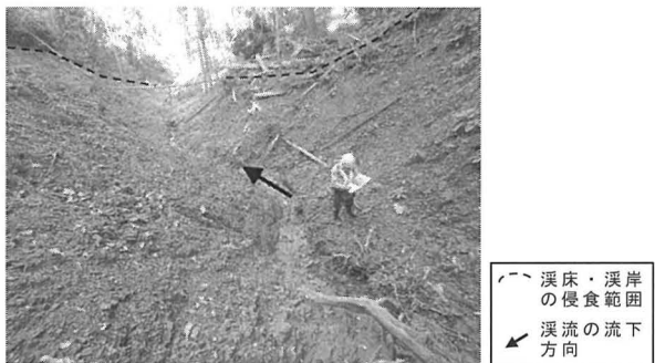
写真5 支溪流の溪岸・溪床の状況
