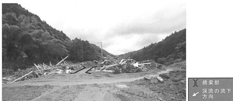
写真17 主溪流における橋梁部の流木の堆積状況
