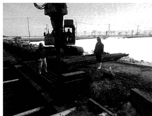
写真-3 継ぎ矢板の実施工事例 10)
