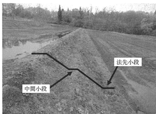
写真-5 法面への小段設置事例（他地区事例）
