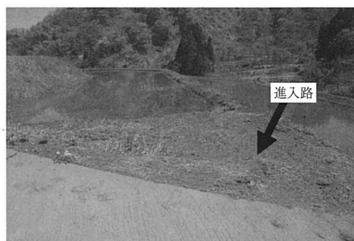
写真-6 平坦性を確保した進入路
