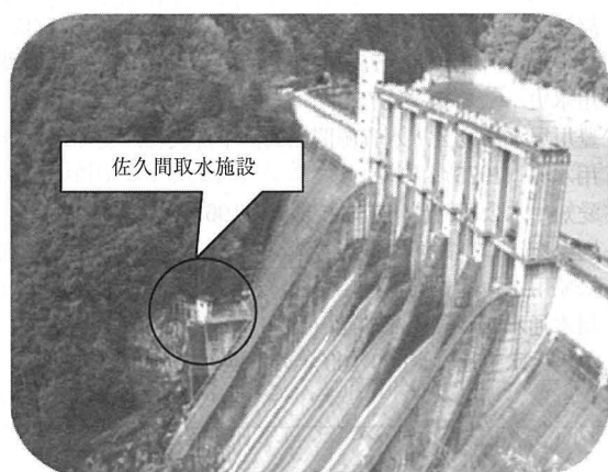
写真-2 佐久間ダムと佐久間取水施設（ともに昭和 31 年完成）
