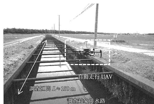
(a) 計測対象施設
