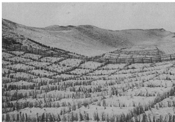
写真2 静砂工（立萱）・植栽の状況（昭和初期）
