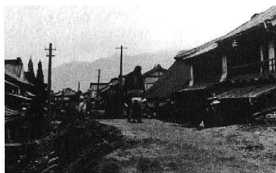
写真4 笛吹市石和町・市部本通り 18) 民家の1階が隠れるほど土砂が堆積
