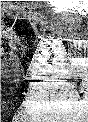
図1 捨て石型（渓床型）実験魚道（10段）全体。
