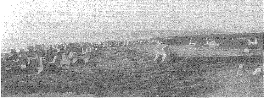
写真21-7 日本海中部地震の津波で秋田県峰浜村の海岸域に打ち上げられた消波工ブロック群（文献7より転載）
