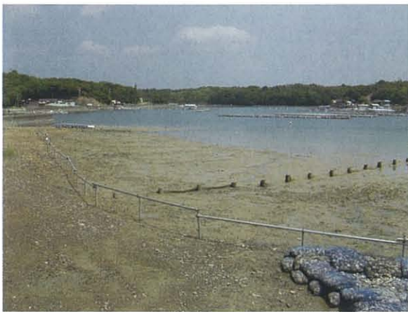
図 3-9 造成工事完成後の概要
