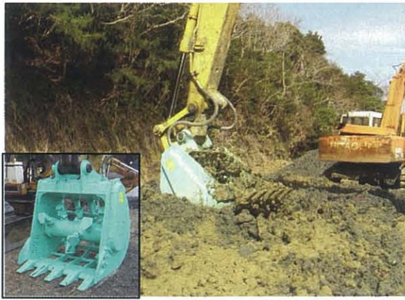
図 3-8 干潟実験区③の造成施工状況
