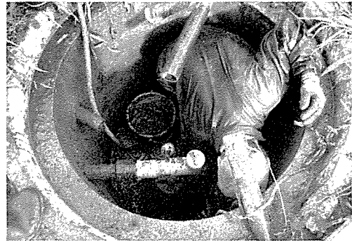
汚水マンホールの汚泥抜き。(写真⑭)
