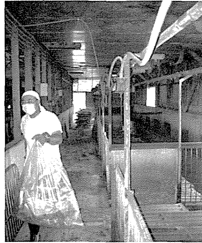
剥がした天井ボード片の片づけ。(写真⑧)
