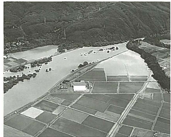
写真1 H18.7月豪雨直後の伊那峡狭窄部の状況 (平成18年7月20日朝、天竜川上流河川事務所撮影)
