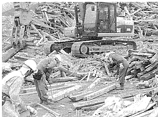
写真4 廃木材チップ化直前の異物除去（山田町）
