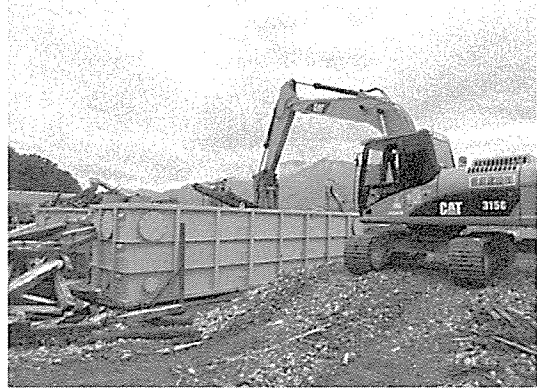
写真1 廃木材の洗浄(大船渡：二次仮置き場)
