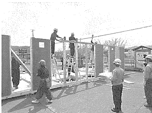
写真5 仮設住宅の試作実験
