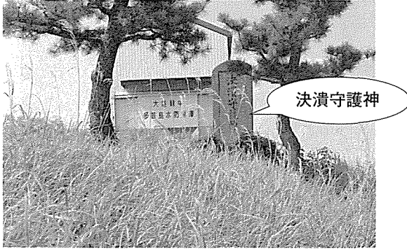
写真5 大垣市多芸島町杭瀬川堤防の決潰守護神の碑 (後ろの建物は多芸島水防倉庫)
