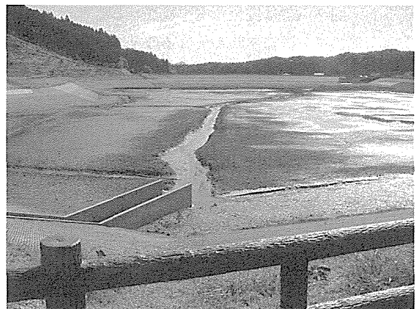
図3 大室ダム内水路
