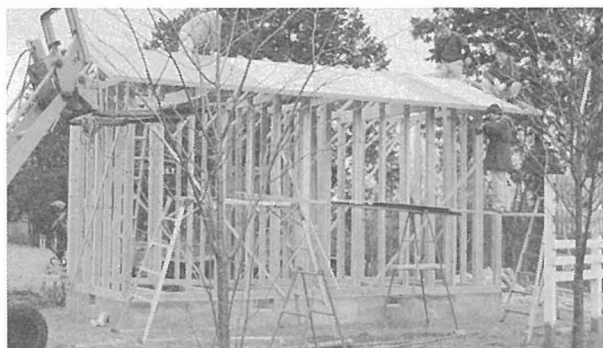
写真1 実験住宅の建設の様子
