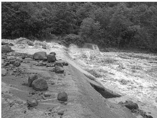
写真27 御嶽野林道洗い越しを流下する火山灰を含んだ濁流 (平成27年 7月)
