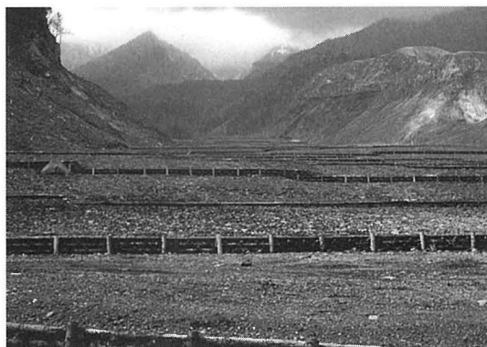
写真8 カラマツ間伐材を使用した丸太土留工（濁川流域）
