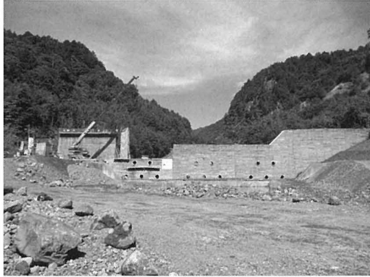
写真20 濁川第64号コンクリート谷止工 ( L=126.5\text{m} H=12.0\text{m} V=6,925.8\text{m}^3 )
