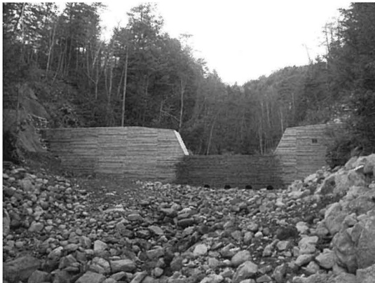
写真19 倉本湯川第1号コンクリート谷止工 (L=43.5m H=6.5m V=912.3m 3 )
