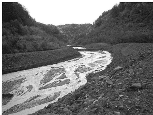
写真16 土石の除去作業の完了
