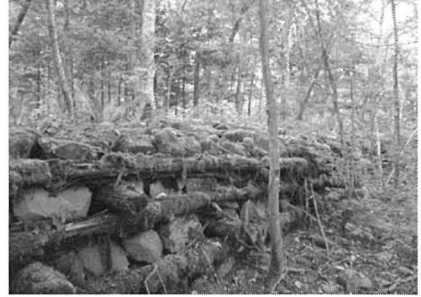
写真11 植栽後30有余年経過した植栽木と復旧事業で施工した丸太土留工
