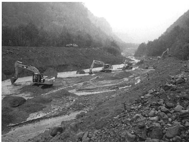
写真15 既設谷止工へ堆積した土石の除去作業中
