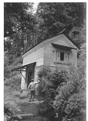
写真-2 明治期末築の小砂石による石蔵
