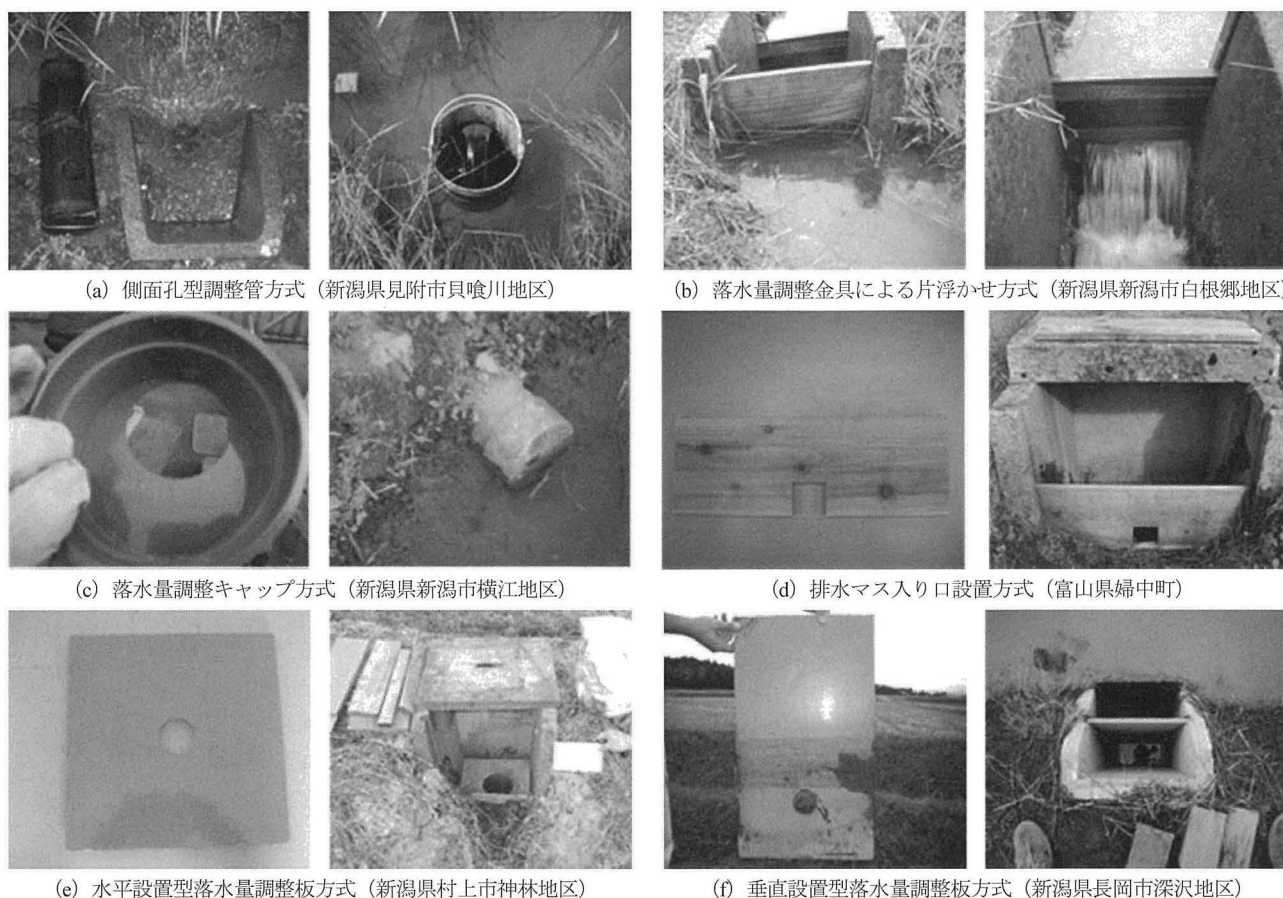
Fig. 1 落水量調整装置の設置事例
