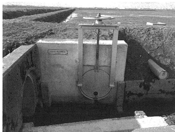
写真-3 孔開き調整ゲート
